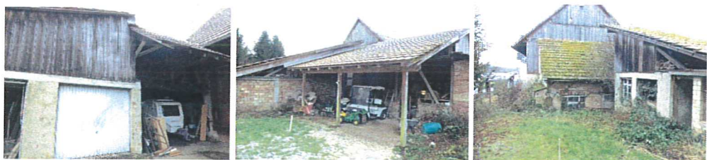
Abbildung 10: Vom Abriss betroffene Gebäude: Garage & Anbauten (Fotos: Kunz GaLaPlan)
